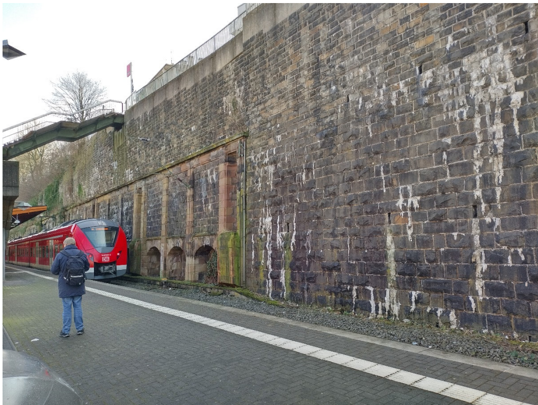
Bild 6: Ansicht der Stützwand zur Absicherung des Geländesprungs zur Straße Distelbeck
