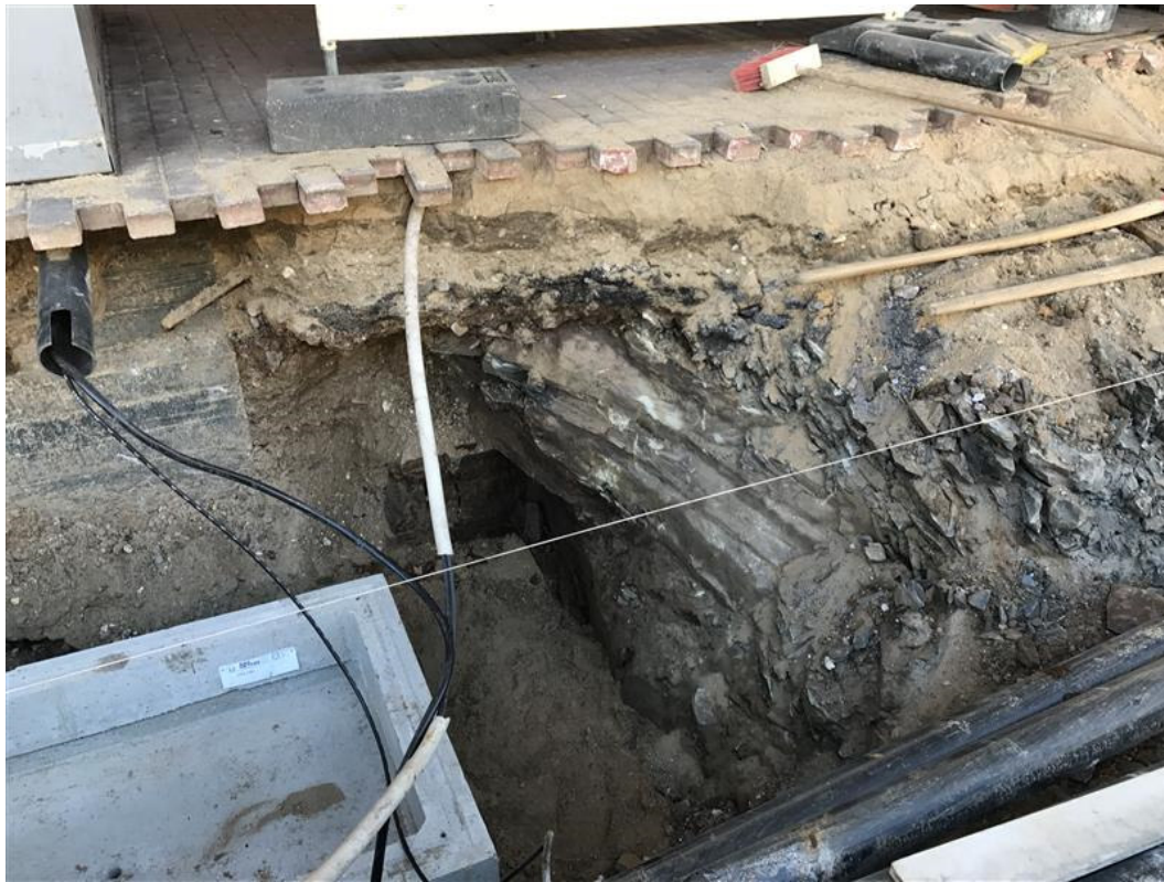
Bild 7: Anstehender Fels in Bahnsteigmitte des Bahnsteigs 2 (Gleis 2&3) im Rahmen von Modernisierungsmaßnahmen 2023
